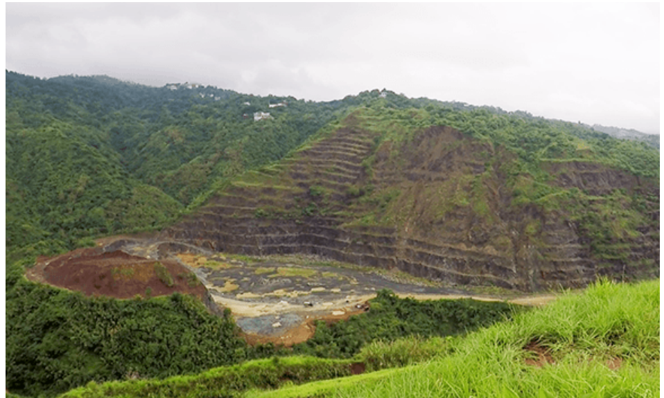
Sayt ng operasyong quarry ng Monte Rock Corporation sa San Mateo, Rizal na sanhi ng malalang pagbaha sa San Mateo, Montalban at Antipolo sa Rizal at ilang lungsod sa Maynila. Noong Agosto 2018, sinira at pinatigil ng BHB-Rizal ang operasyong quarry ng Monte Rock bilang tugon sa hinaing ng mamamayan.
